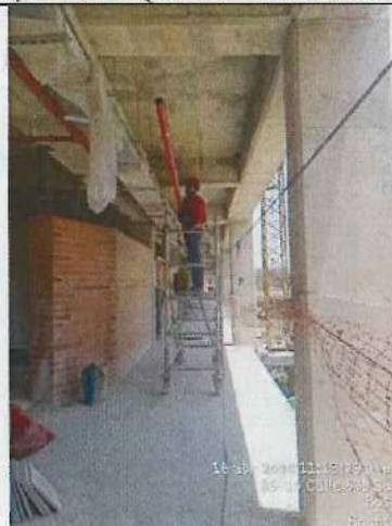
INSTALACION DE TUBERIA RCI NIVEL 4,20 BLOQUE 1 - 16/04/2024
