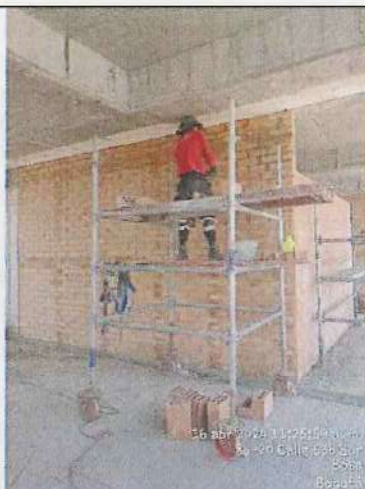
INICIO APUNTALAMIENTO PARA REPARACION PANTALLAS BLOQUE 4 - 17/04/2024
