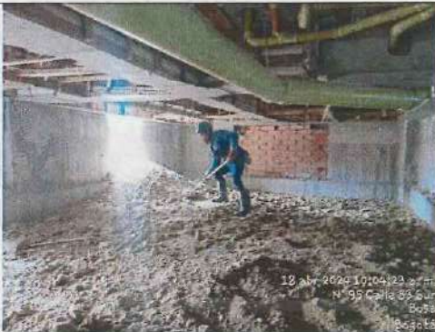
REPARACION DE ZAPATAS DE CIMENTACION BLOQUE 3 - 18/04/2024
