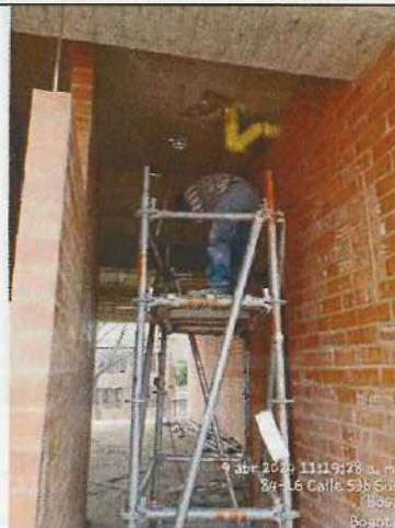
RESANE DE TORTA INFERIOR NIVEL 4,20 BLOQUE 6 - 09/04/2024
