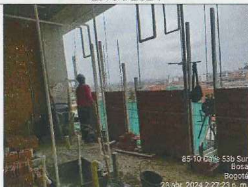
ARMADO DE ACERO PARA TANQUE DE SUMINISTRO - 29/04/2024
