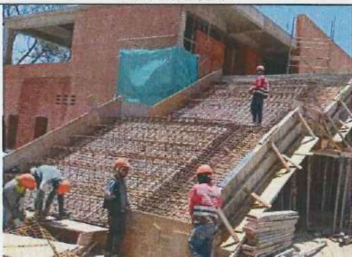
ARMADO ESCALERA Y GRADERIA NIVEL 0,50 AL 4,20 BLOQUE 7 - 10/04/2024
