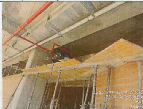
INSTALACION DE TUBERIA RCI NIVEL 4,20 BLOQUE 1 - 16/04/2024
