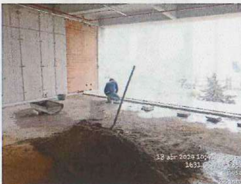
INSTALACION DE PISO VIBRO PRENSADO NIVEL 11,80 BLOQUE 2 - 18/04/2024
