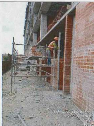
MAMPOSTERIA EN LADRILLO FACHADA NIVEL 0,00 BLOQUE 7 - 09/03/2024
