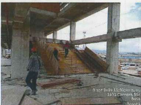
ARMADO ESCALERA Y GRADERIA NIVEL 0,50 AL 4,20 BLOQUE 7 - 10/04/2024
